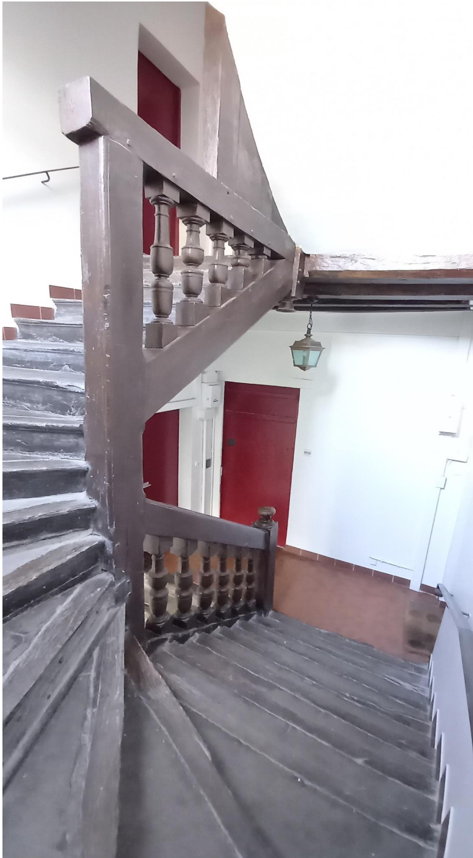
Grand escalier du XVIIe, dit des « Mousquetaires », de l'Hôtel du Bel Air : aucun des huit escaliers du site (quatre du XVIIe et quatre du XIXe), n'est protégé
