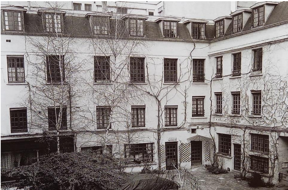
Côté nord-ouest de la Cour du Bel Air, où se trouve le premier escalier menacé. Cette cour emblématique est l'un des derniers lieux de mémoire préservés du Faubourg Saint-Antoine
